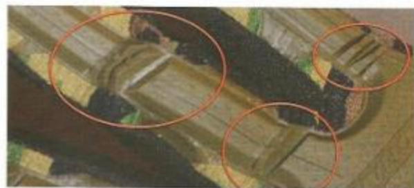
> Les soufflets des renforts se déforment à l'utilisation, évitant ainsi une trop forte rigidité
